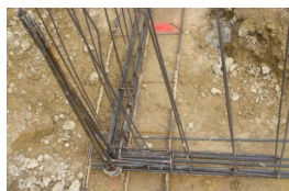
Noeud de chaînage - Continuité mécanique
